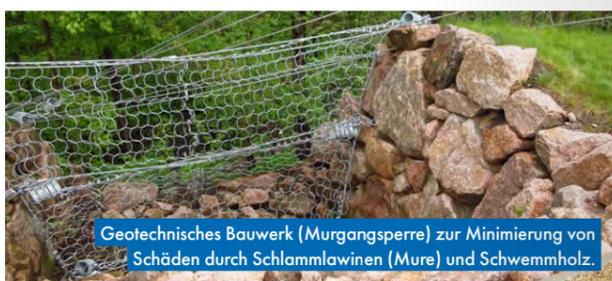
Geotechnisches Bauwerk (Murgangssperre) zur Minimierung von Schäden durch Schlammlawinen (Mure) und Schwemmholz.
